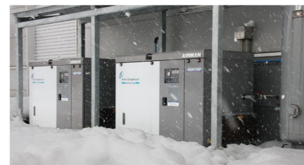
製造工場 SMS15SD×2台
